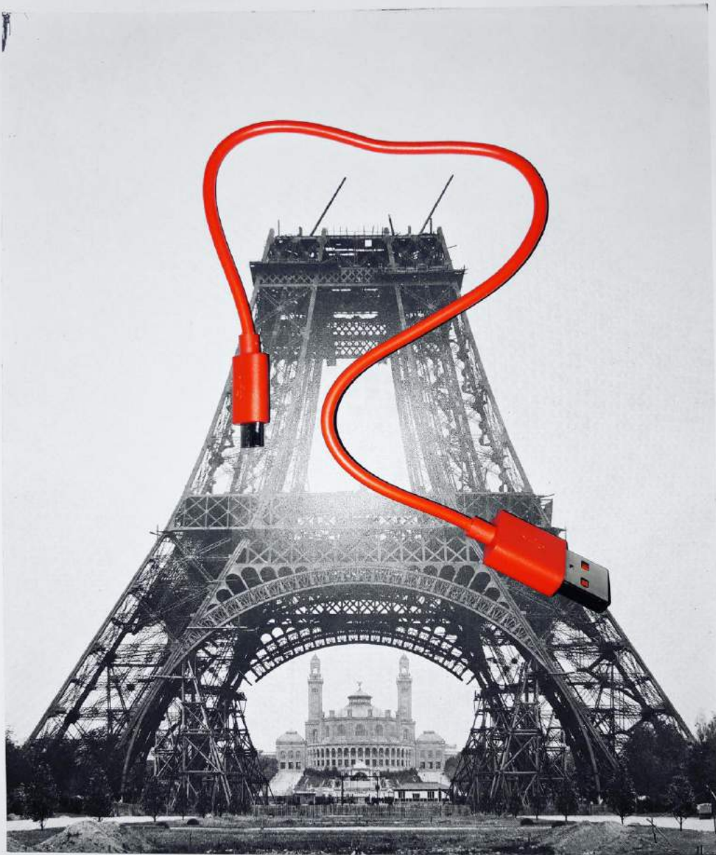
LA TOUR EIFFEL EN CONSTRUCTION: 1888
